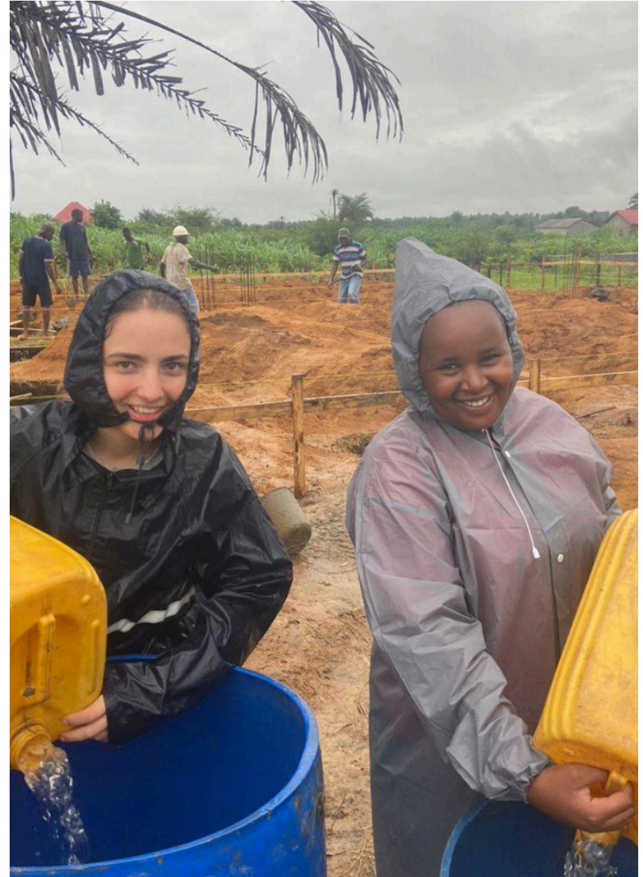
Vrijwilligers halen water uit de put om beton aan te maken
