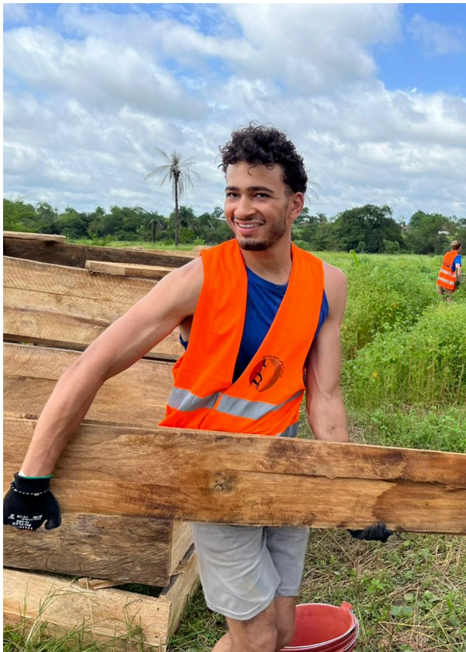
..Vrijwilliger Ahmad verplaatst een plank voor het maken van de bekisting
