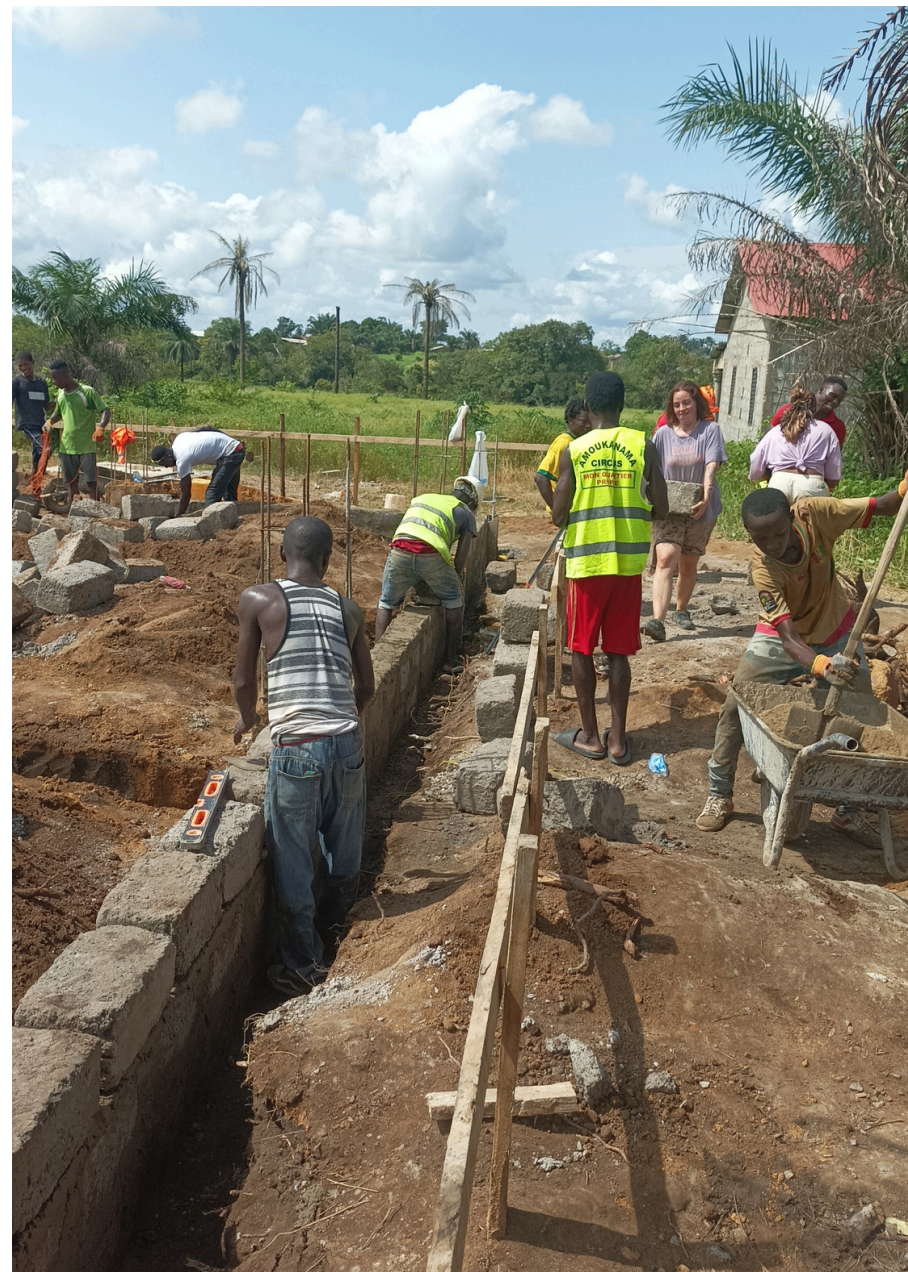
Vrijwilligers, acrobaten en arbeiders werken samen om de muren te plaatsen
