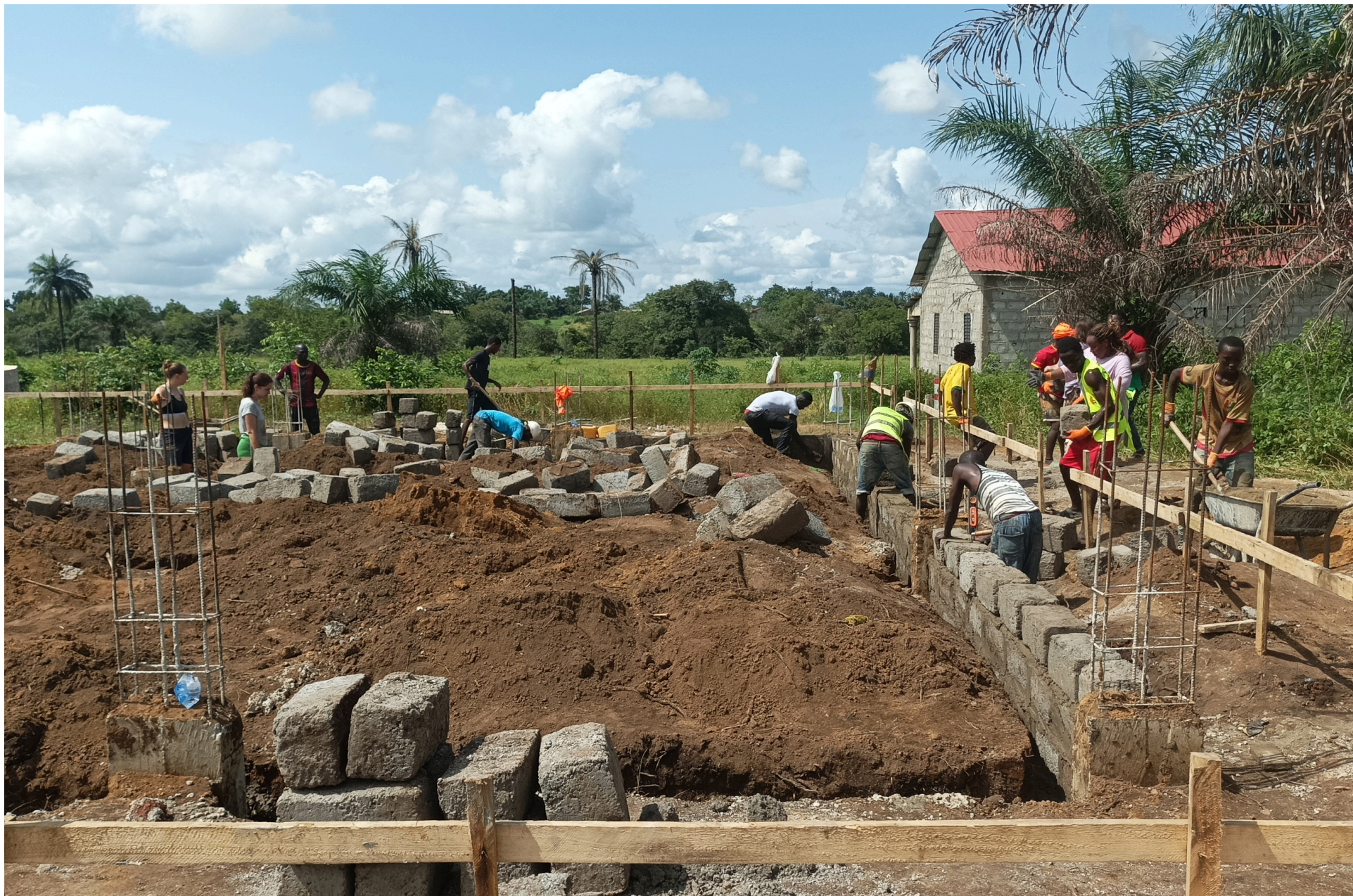
Vrijwilligers, acrobaten en arbeiders werken samen om de muren te plaatsen
